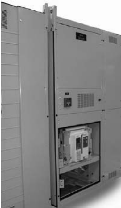
El diseño de chasis individual ofrece flexibilidad para el Servicio.
